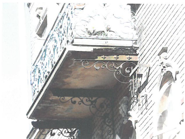
BALKONY od strony ul. Kazimierza Wielkiego uszkodzenia konstrukcji wspornikowej ( stalowej ) oraz płyty żelbetowej
