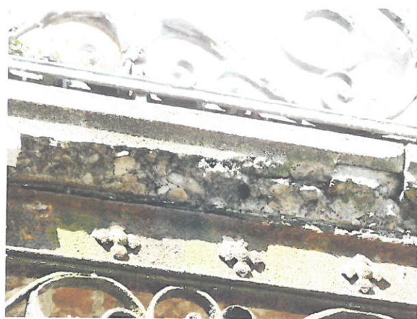
BALKONY od strony ul. Kazimierza Wielkiego uszkodzenia konstrukcji wspornikowej ( stalowej ) oraz płyty żelbetowej
